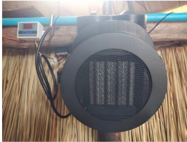
ภาพที่ 4 ติดตั้งฮีตเตอร์และเซ็นเซอร์ควบคุมอุณหภูมิ เพื่อใช้ในการตั้งค่าการทำงานของฮีตเตอร์แบบอัตโนมัติ
