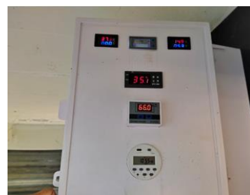
ง) ภาพหน้ากล่องควบคุมอุปกรณ์
