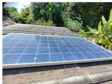
ข) ภาพติดตั้งแผงโซลาร์เซลล์
